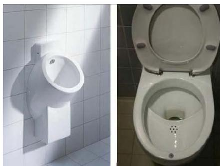
Figura 8: Mictório sem descarga de água e Sanitário com separação de urina em prédio de escritórios na cidade de Eschborn, Alemanha
