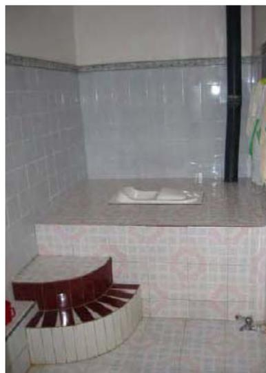
Figura 7: Sanitário seco de câmara dupla para separação de urina e fezes utilizado em Nanning Guangxi, na China – zona rural
