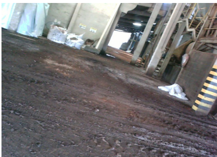
Figura 2: subproduto gerado no piso decorrente do armazenamento inadequado da matéria-prima (ureia).
