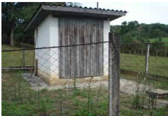
Figura 3. Poço artesiano da comunidade Rio Vinagre, em Rio Azul/PR
