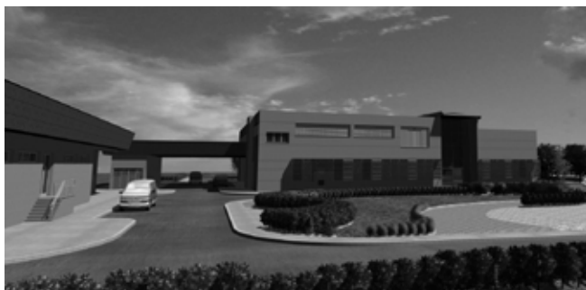
Figura 2 - Imagem da fachada oeste.
